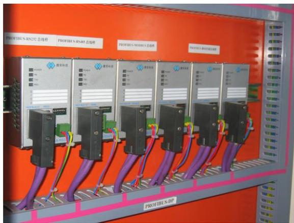
图 3-8 连接 PROFIBUS 设备的标准 PROFIBUS 插头
